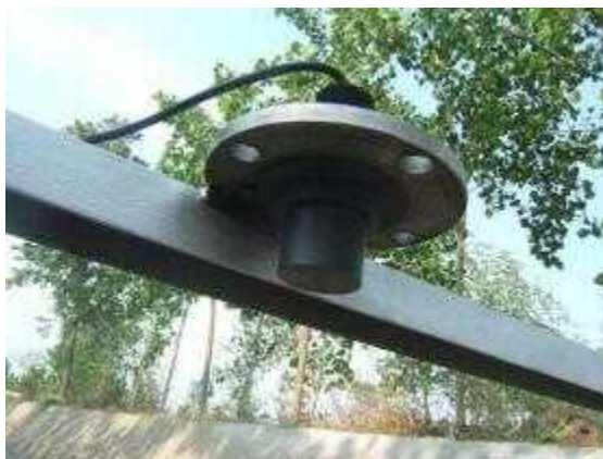
图 3-8 安装完成的换能器
