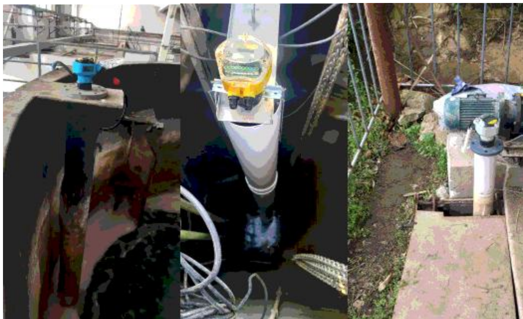
图 11.4 整根导管安装案例图
