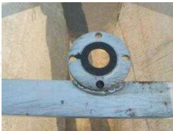
图 3-2 法兰上放一片内径相同的垫片
