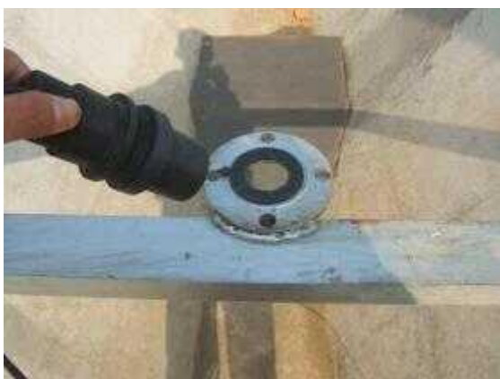
图 3-3 把换能器对准法兰孔
