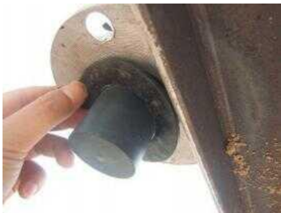
图 3-6 法兰下放一片内径相同的垫片
